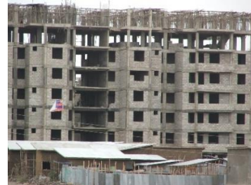
nieuwbouw wijken in aanbouw
